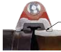
Voller Kontakt zwischen Kupplungspassfeder Figur 577 und Nutgrund
