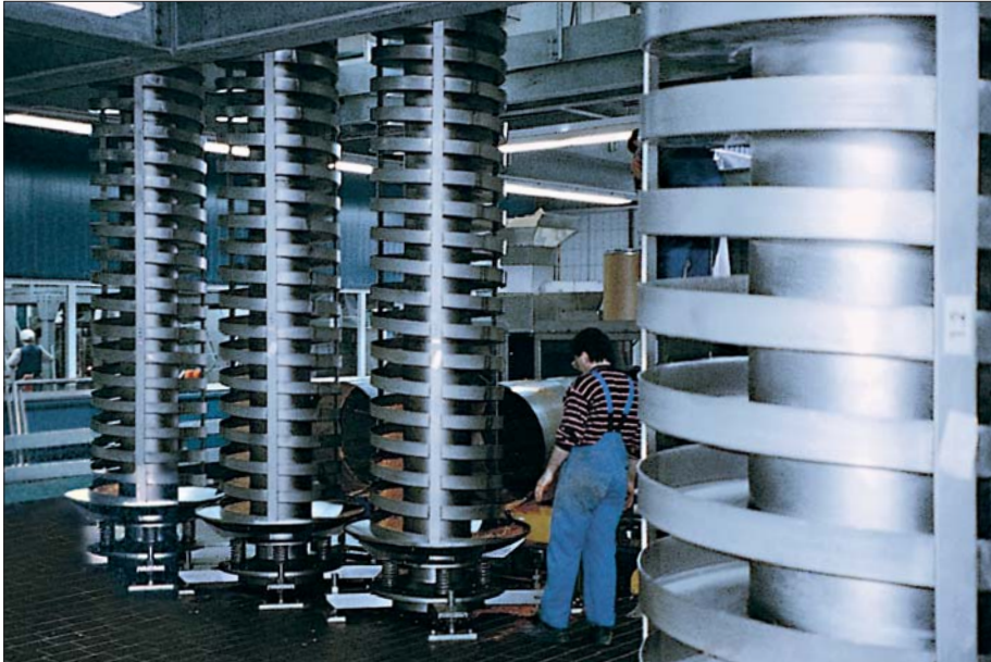
Bild 29: Vier Wendelförderer in einer Nahrungsmittelfabrik
