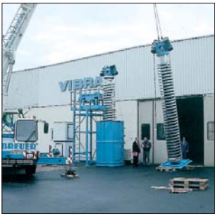
Bild 27 Probemontage von Wendel- förderern mit stationärem Staubschutzgehäuse
